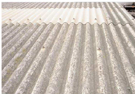
Cubierta de fibrocemento en nave industrial
